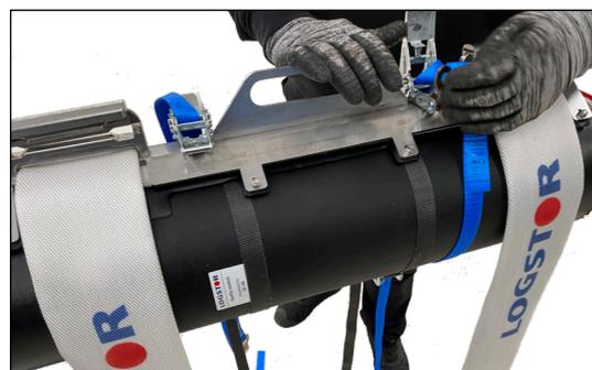
Das Druckwerkzeug nach oben zum Anschlag gegen die Gummischiene an der Stahlschiene schieben, so die Schiene mit der Kante der Überlappung fluchtet.
