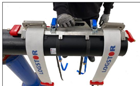
Die Spannbänder des Druckwerkzeuges locker um die Muffe platzieren.
